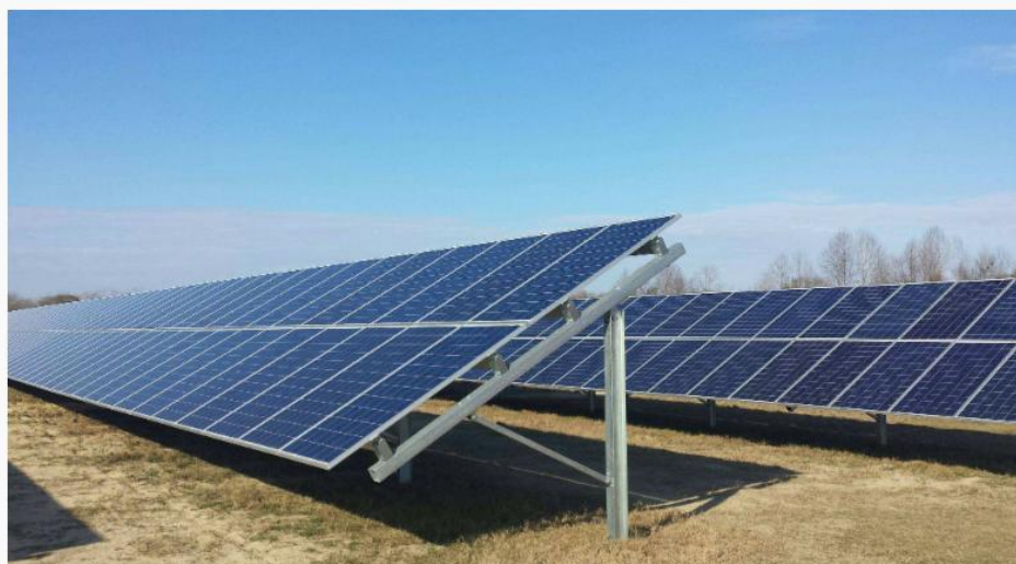
Hình 1.3: Sơ đồ minh họa hệ thống giá đỡ pin với móng cọc thép
